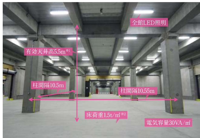
倉庫 □照明：平均200ルクス(床面) ※1:1階のみ有効天井高6.75m ※2:1階のみ床荷重2.0t/m²
